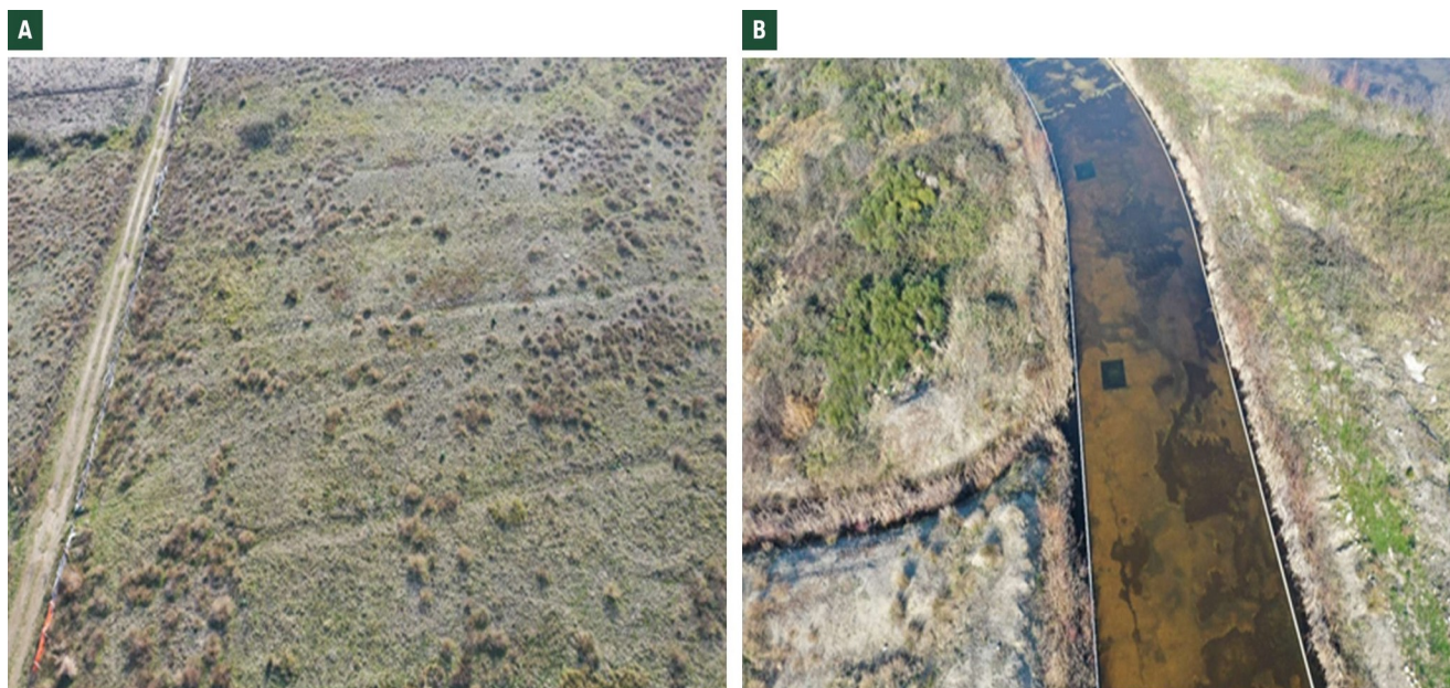
Slika 8. Izvorni prikazi antropogenog predjela na UP22: A – izmijenjena površina i neformalna trasa; B – postojeći obloženi kanal
