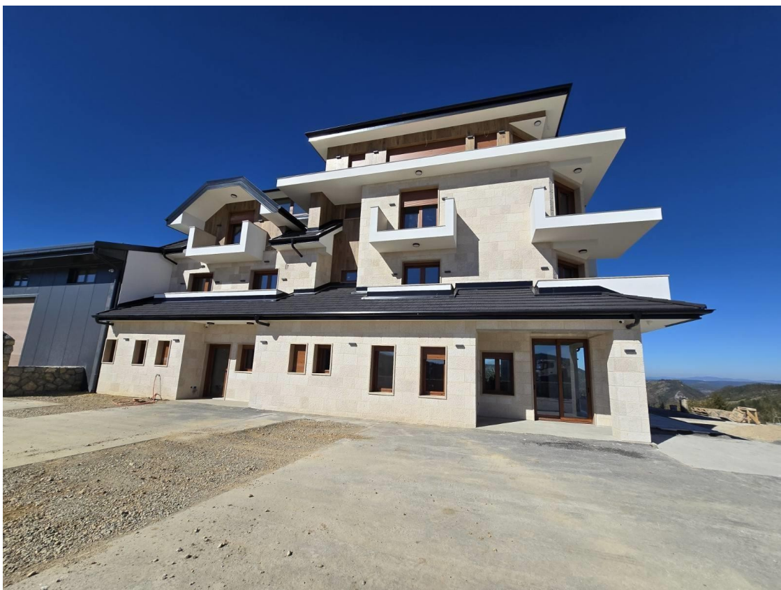
Fotografija P1.3 – Postojeće stanje objekta KO Gradina.
