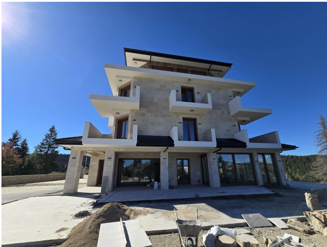
Fotografija P1.1 – Postojeće stanje objekta KO Gradina.
