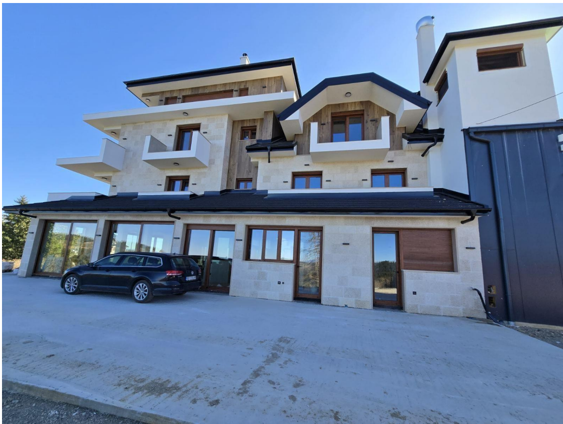
Fotografija P1.2 – Postojeće stanje objekta KO Gradina.
