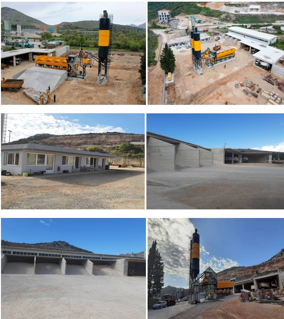
Sl. 2.8 - 2.15. Proizvodni kompleks koji čini betonska baza, boksevi za smještaj agregata, drobilčno postrojenje i hala za potrebe proizvodnog kompleksa
