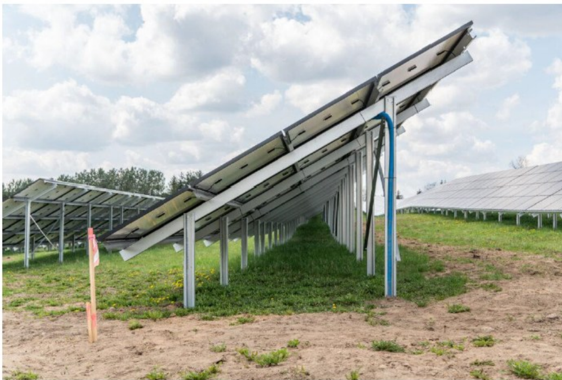
Sl. 3.a.25. Ilustracija podkonstrukcije za FN module.
