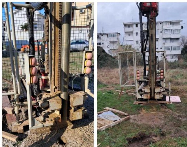
Slika broj 2: Fotografije sa lokacije snimljene pri izvođenju istražnih radova
