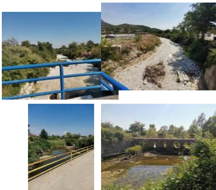
Slika 8 – Postojeće stanje potoka Vladimir kod betonskog mosta
