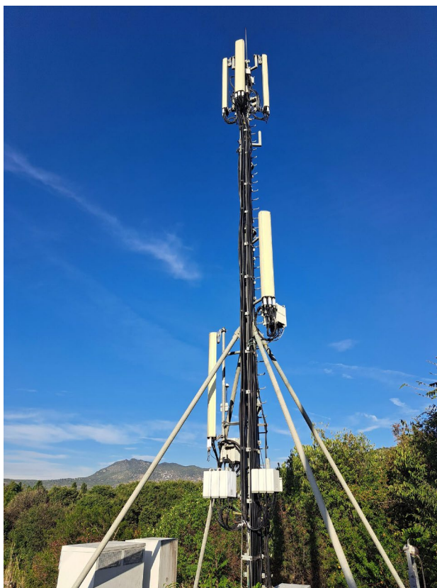
Slika 2.3. Izgled postojećeg antenskog stuba na lokaciji
