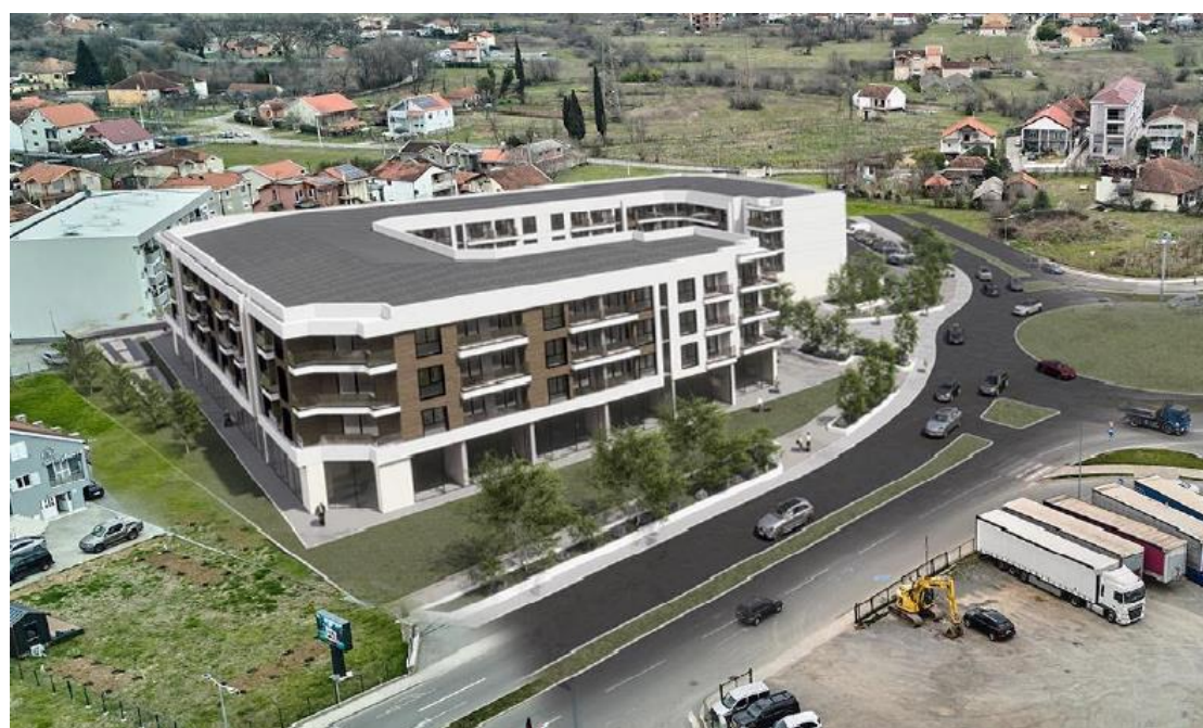
Slika 5. 3D prikaz objekta na lokaciji sa užom okolinom
