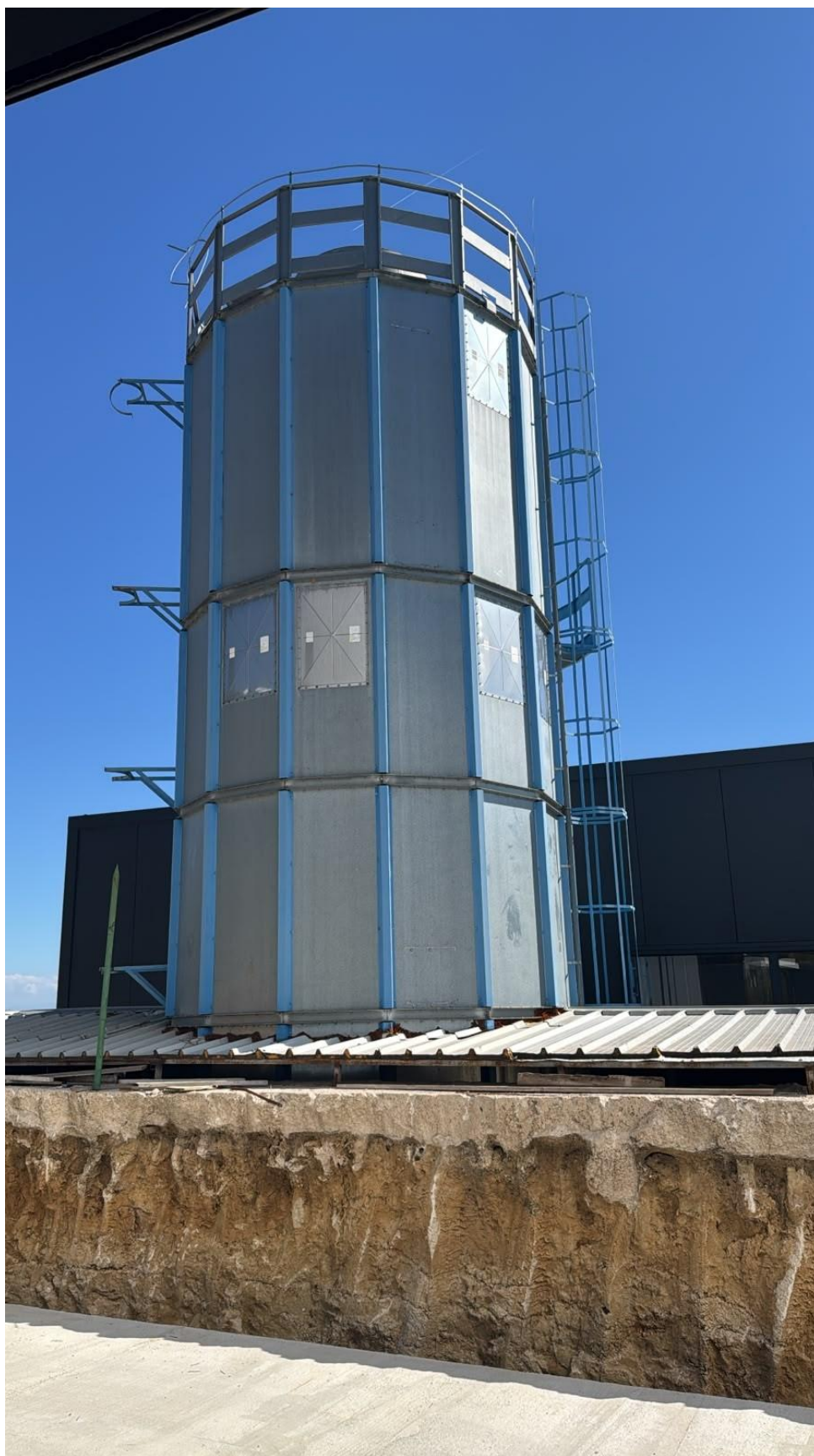
Fotografija 3. Spoljašnja tehnička jedinica/silos sistema aspiracije - postojeće stanje.
