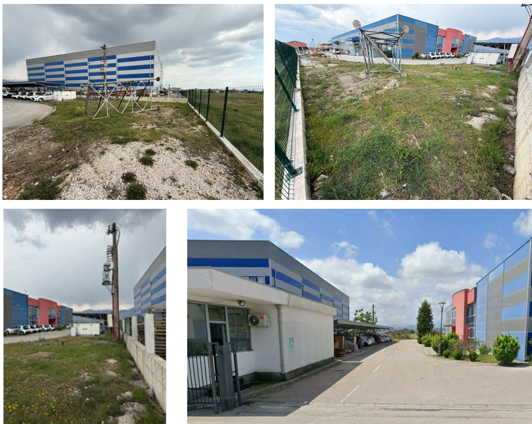
Slika 2.3. Izgled lokacije i neposrednog okruženja
