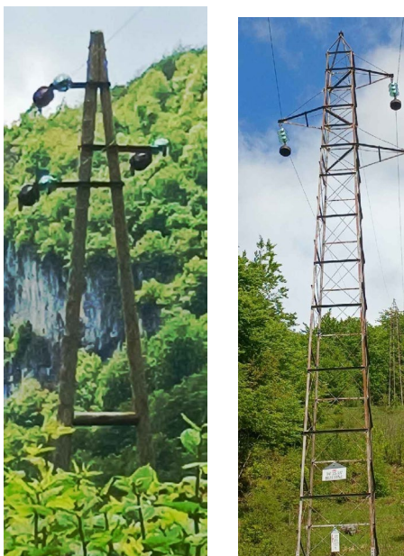
Slika 3-6: Postojeće stanje – lijevo: drveni „A“ stub br. 74 na DV 35 kV Kolašin (Breza) – Rijeka Mušovića, mjerene visine do donje konzole h = 7,5 m; desno: željezni nosivi stub br. 1 na DV 35 kV Rijeka Mušovića – Jezerine, h = 12,32 m
