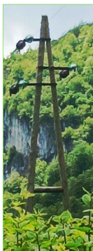
Postojeći drveni "A" stub br.74 mjerenevisine do donje konzole h=7.5m (kota +1110,908 Auz 7.5 JZP/JZP
