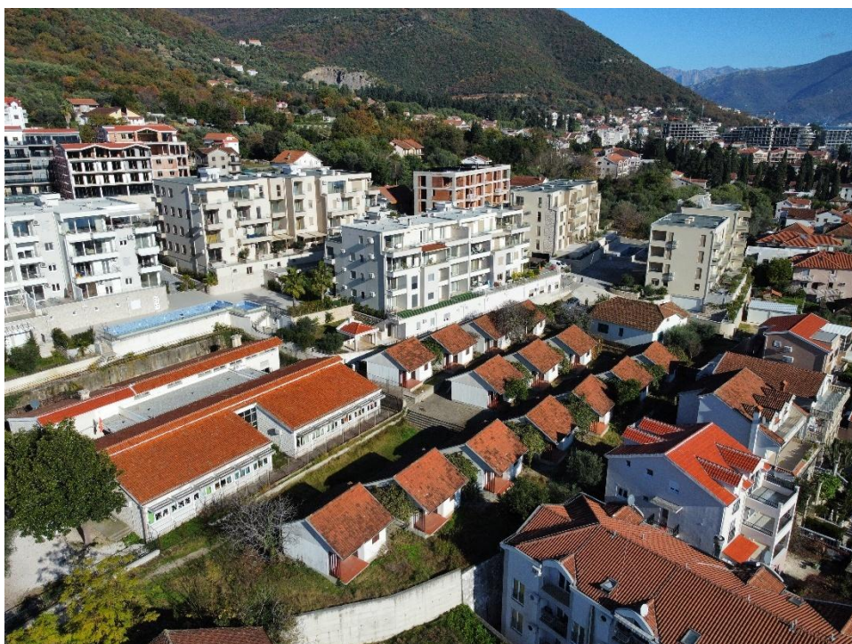
Slika 2.1.2. Pogled sa južne strane lokacije
