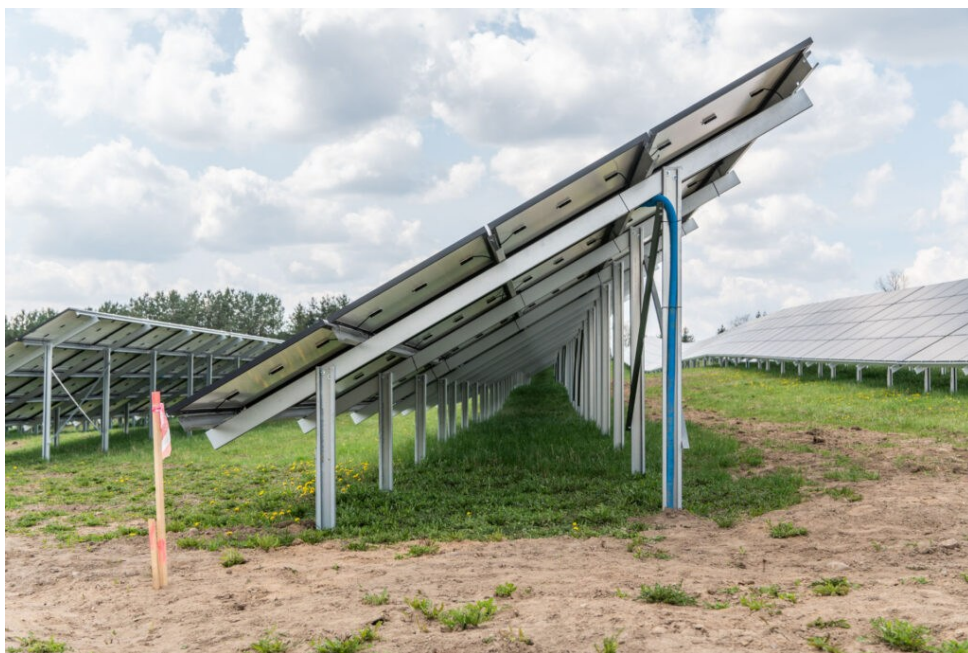
Sl. 3.4.15.. Ilustracija podkonstrukcije za FN module.
