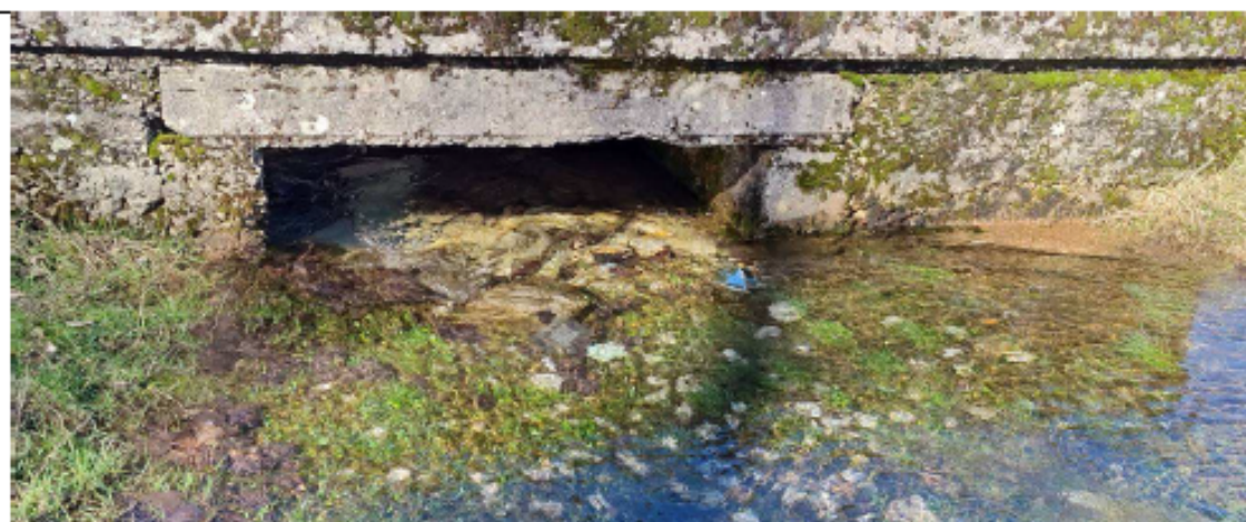
Slika 2.15. Zona protoka 5 – površinski tok i postojeći mali most na zapadnom dijelu lokacije Izvor: Elaborat o geotehničkim i geofizičkim istraživanjima terena, februar 2026.
