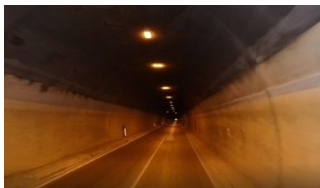
Slika 3.3. Fotografija sekundarne obloge, kolovoza i osvjetljenja
