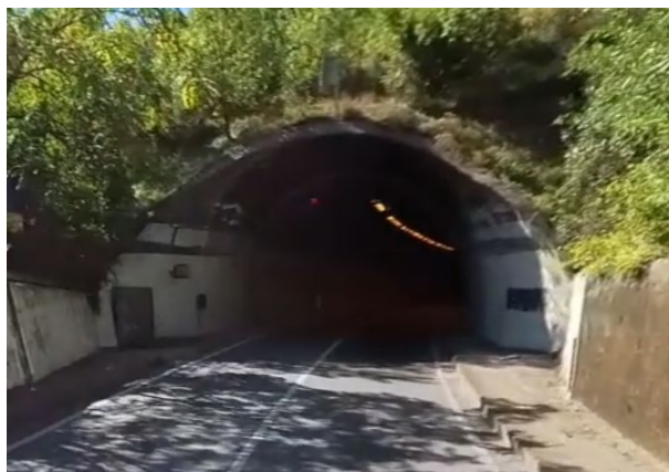
Slika 3.8. Pogled na portal tunela
