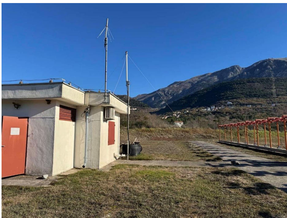
Slika 0-3: Postojeći objekat (a)
