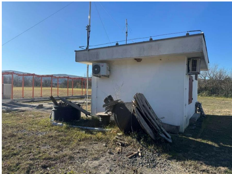
Slika 0-4: Postojeći objekat (b)
