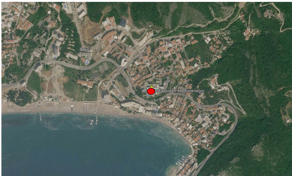
Slika 2.1. Lokacija bazne stanice (●)
