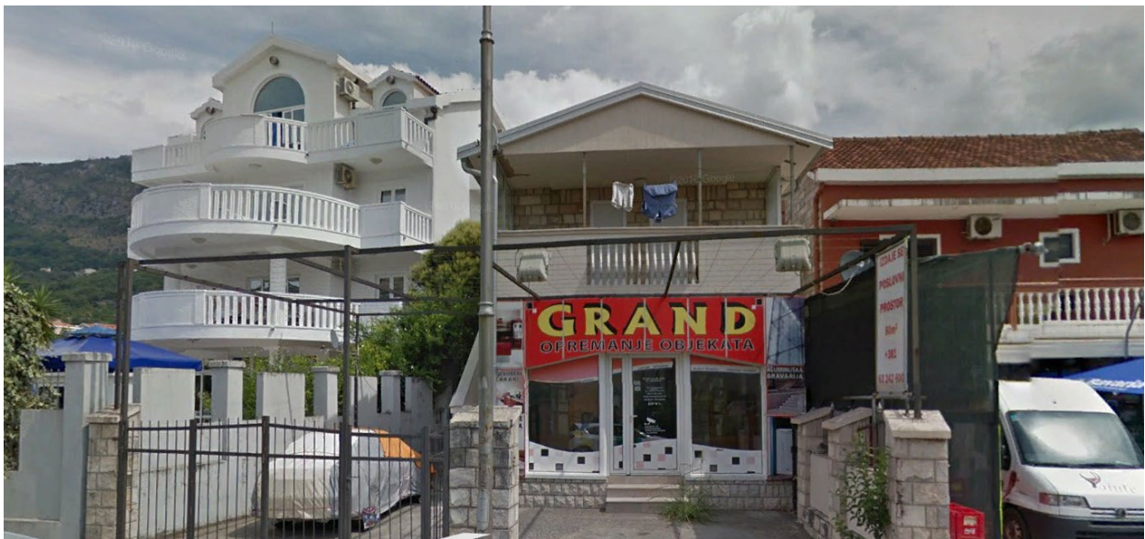
Slika 4. Objekat na kome je planirana instalacija opreme u odnosu na okolinu
