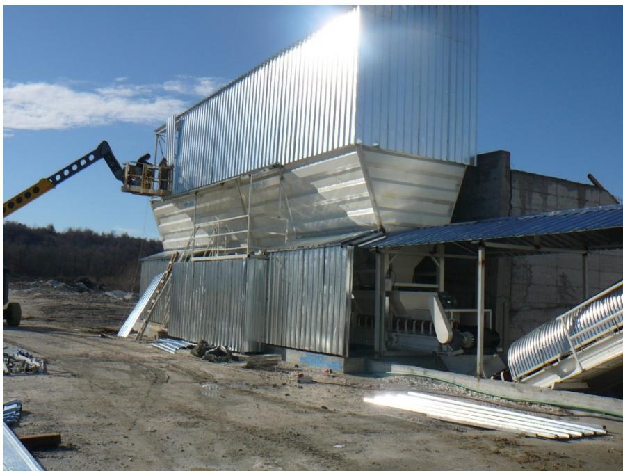
Slika 25. Bunker za smještaj drobljenog materijala granulacije 0-4 mm
