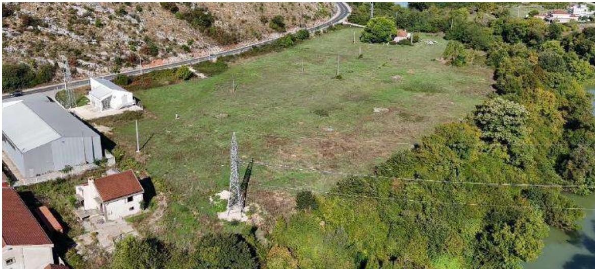
Slika 4. Postojeći izgled lokacije objekta
