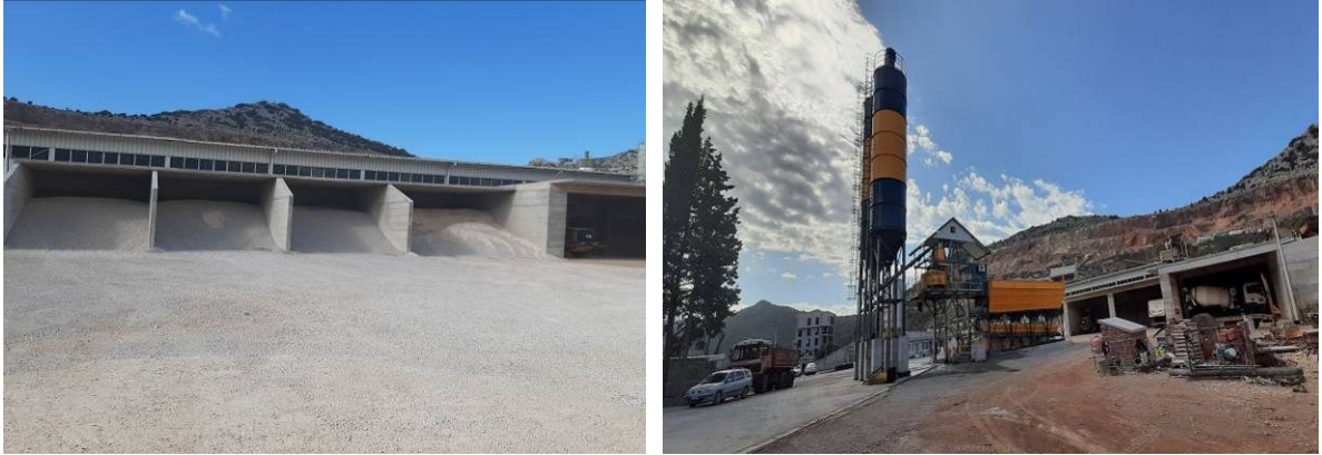
Sl. 2.8 - 2.15. Proizvodni kompleks koji čini betonska baza, boksevi za smještaj agregata, drobilčno postrojenje i hala za potrebe proizvodnog kompleksa
