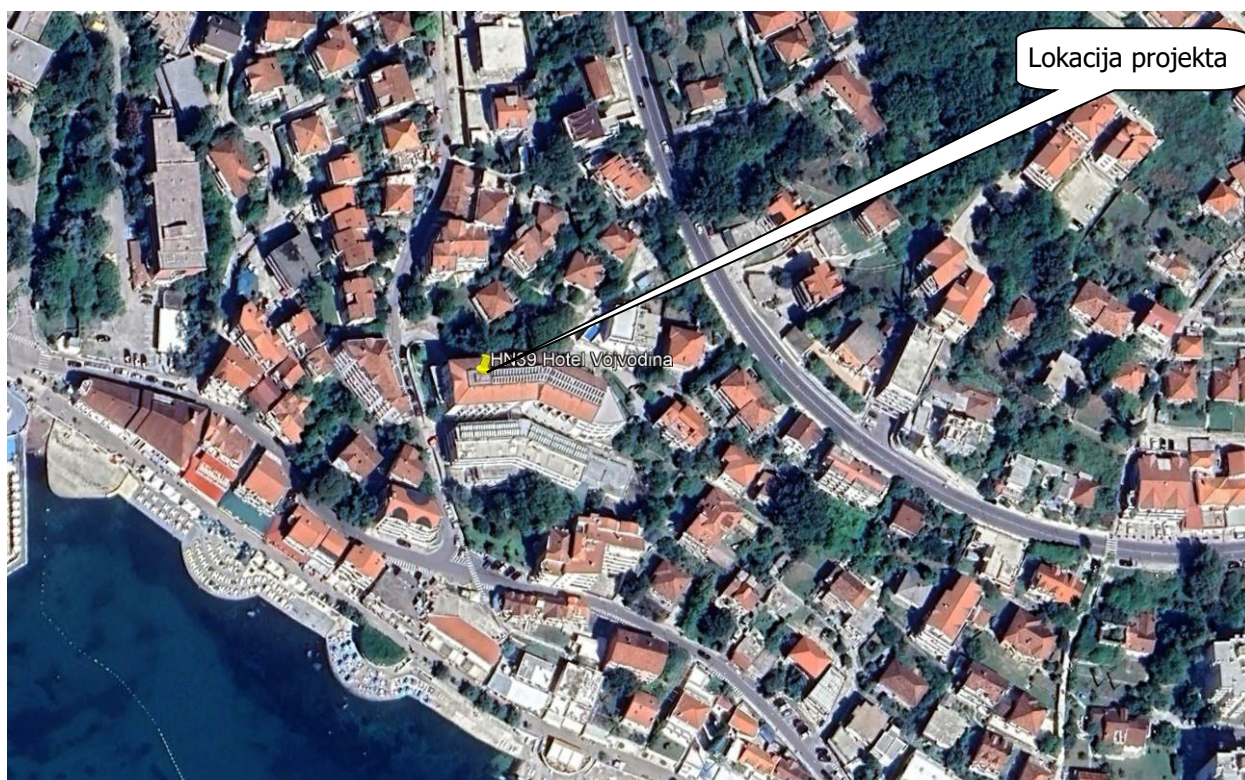
Slika lokacije 2.1. Lokacija bazne stanice
