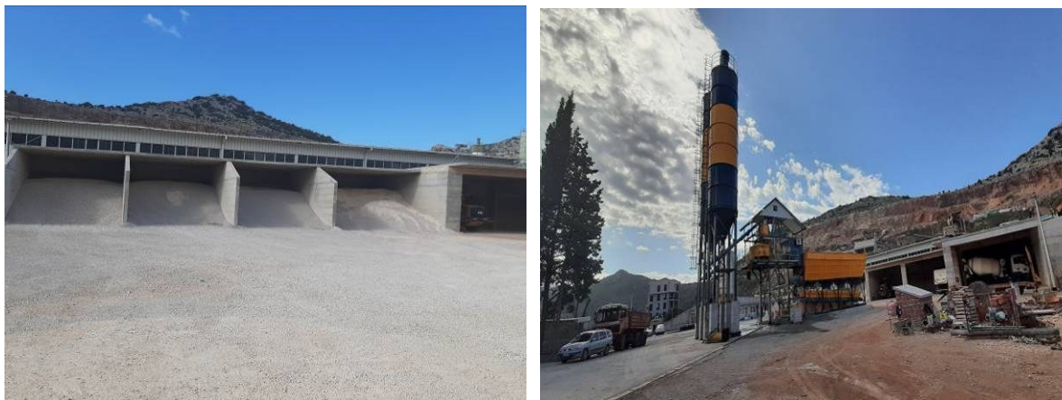
Sl. 2.8. - 2.15. Proizvodni kompleks koji čini betonska baza, boksevi za smještaj agregata, drobilčno postrojenje i hala za potrebe proizvodnog kompleksa
