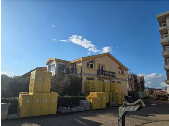
Slika 4. Prikaz objekta broj 1 (broj zgrade 1 na k.p.3788/1) koji se uklanja.
