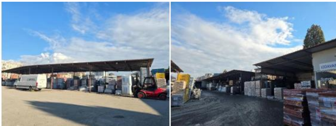
Slike 6 i 7. Metalne nadstrešnice oko objekata koje se uklanjaju
