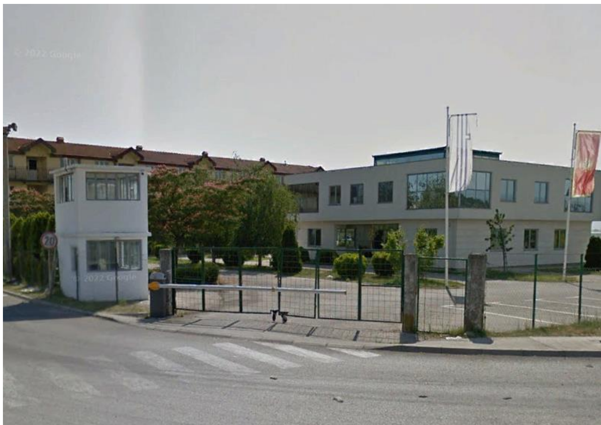
Slika br.2.3.-Upravna zgrada
