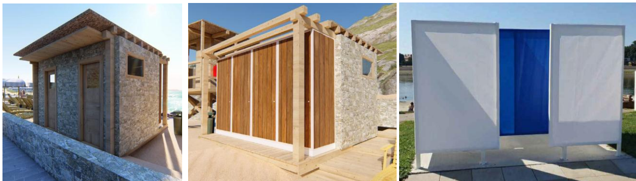
Slika 17. Sanitarni objekat, tuš kabine i kabine za presvlačenje
