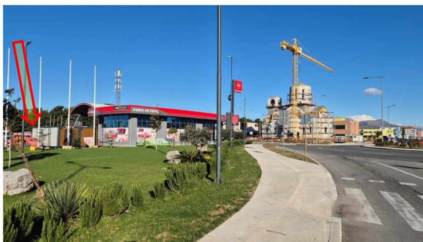
Slika 2.2. Izgled lokacije sa postojećom benzinskom stanicom i okolnim objektima u izgradnji
