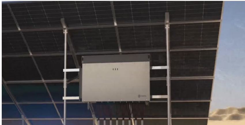
Slika 67: Način postavljanja invertora
