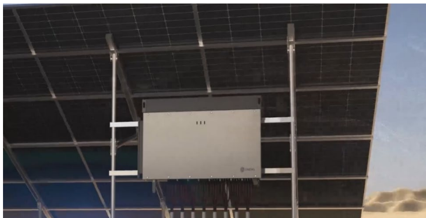
Slika 81: Način postavljanja invertora
