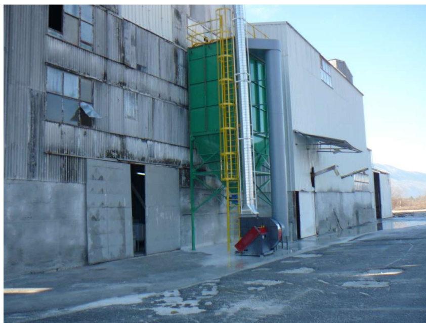
Slika 23. Filterski sistem instaliran u sklopu pogona za proizvodnju praškastih materijala (mašinskog maltera i ljepila)
