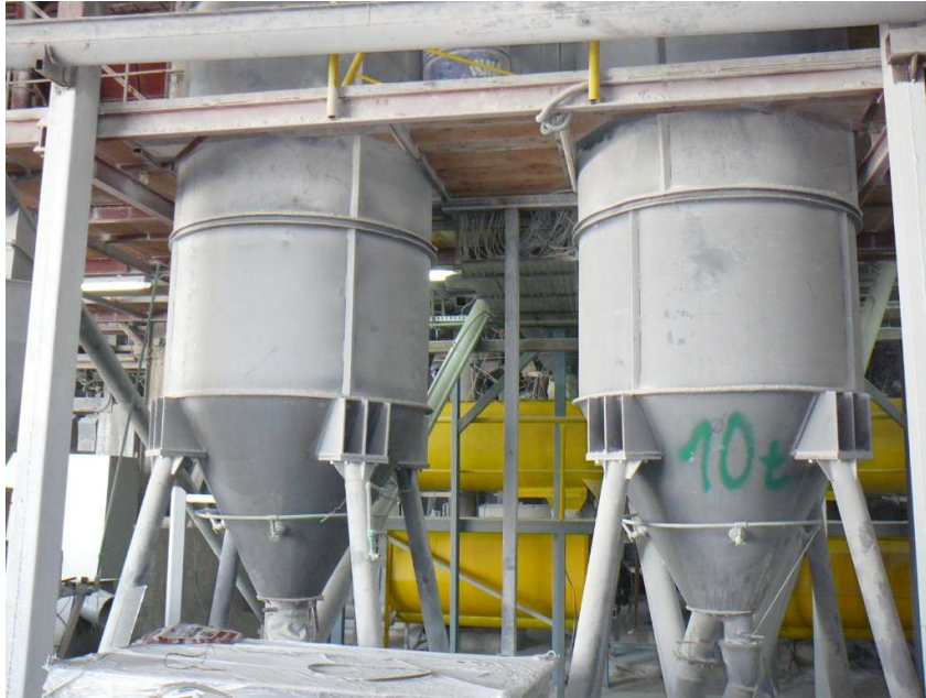
Slika 20. Silos za cement i kreč
