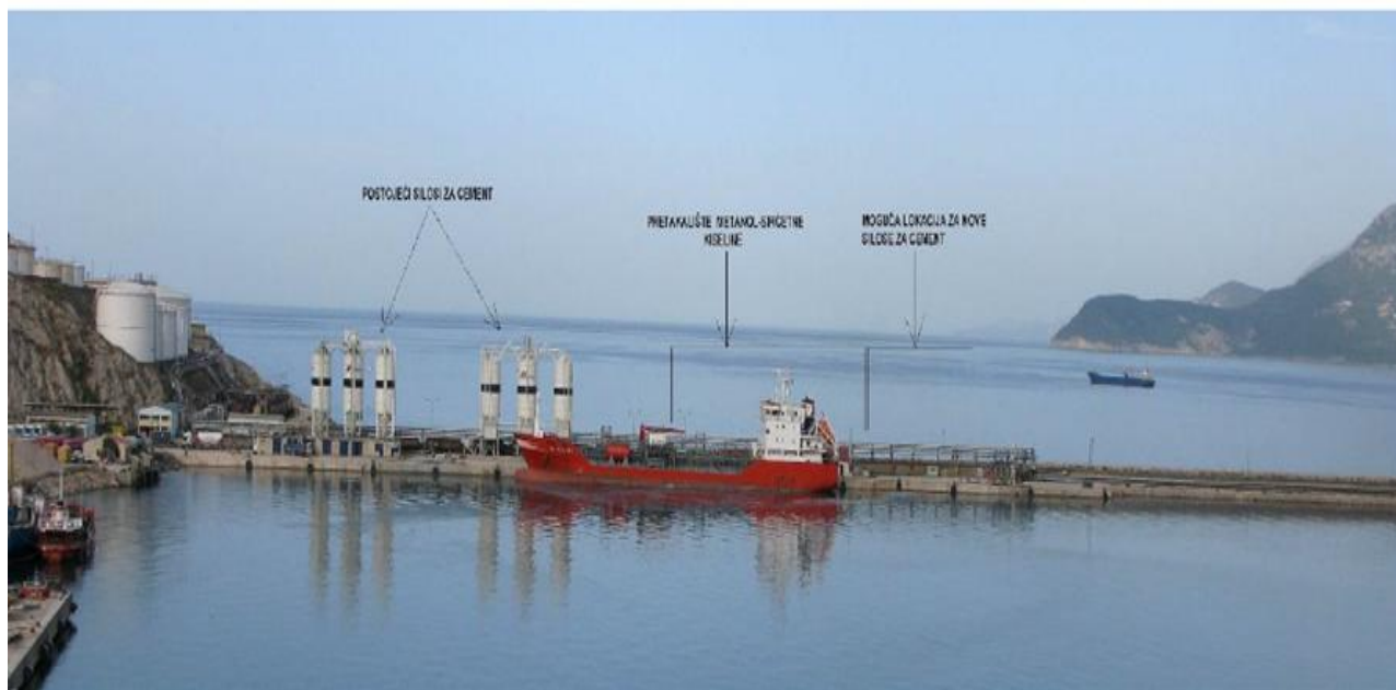
Slika 2.2. Glavni lukobran sa postojećim objektima
