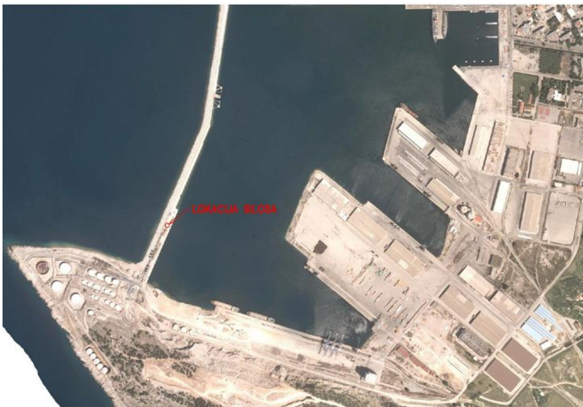
Slika 2.1. Lokacija budućeg privremenog objekta-silosa za cement
