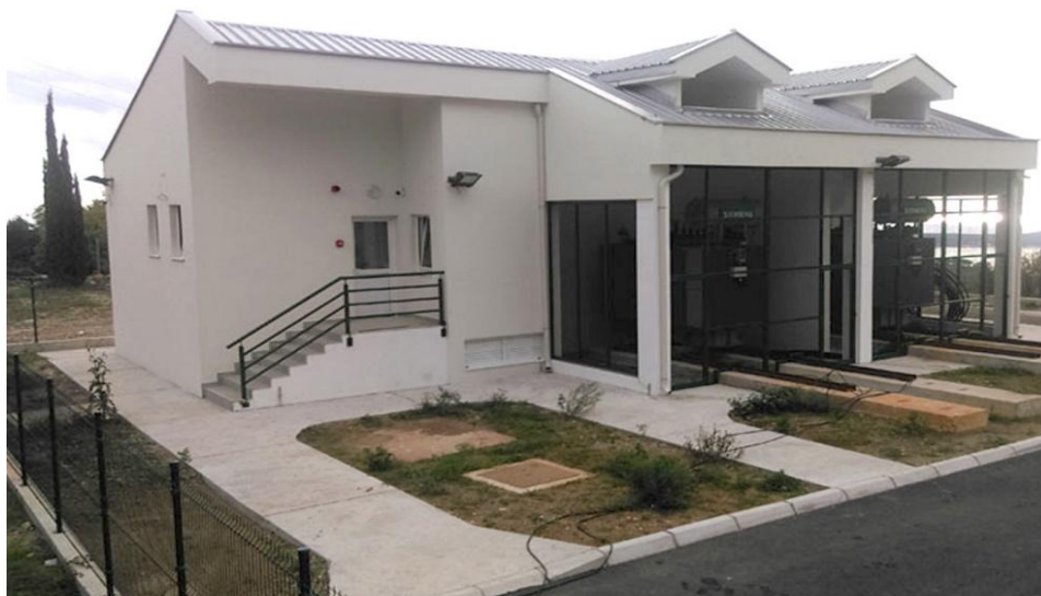
Slika 3.1.2. Primjer jedne TS 35/10 kV, 2x8 MVA
