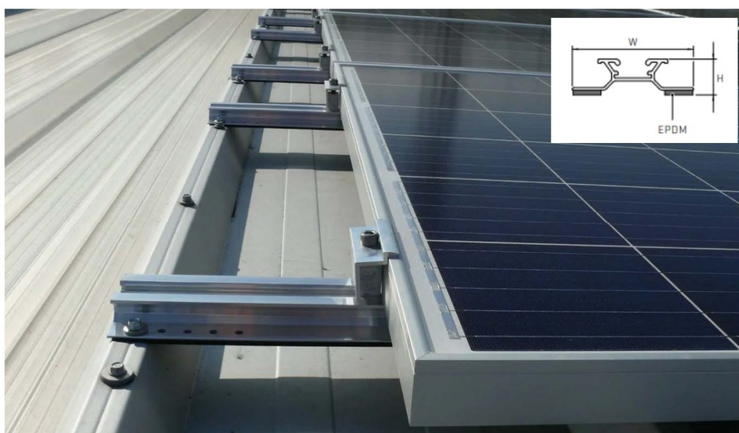
Sl. 3.1.4. Detalj montaže modula na Mini Rail sistemu proizvođača K2 Systems
