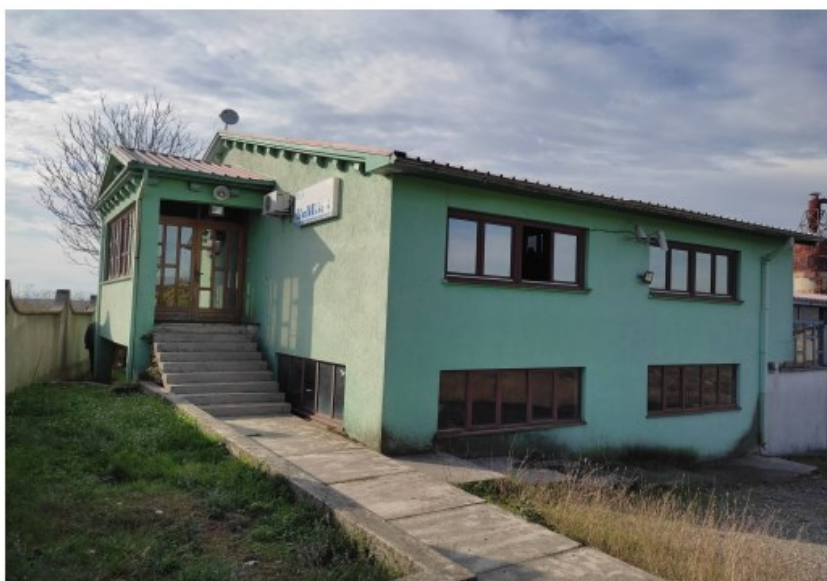
Sl.3.a.3. Postojeći objekat 3
