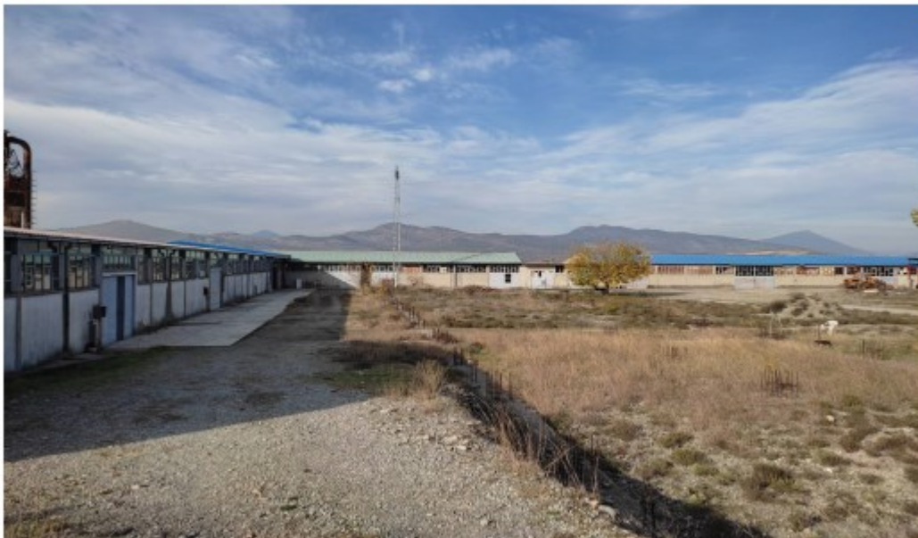
Sl.3.a.2. Postojeći objekat 1
