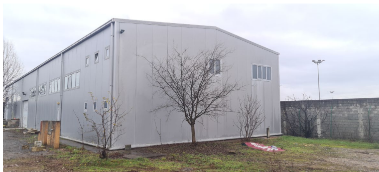
Slika 3.1. Izgled objekta u kojem se planira projekat
