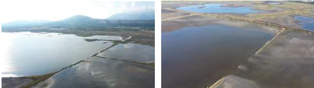
Slike 3. i 4. Prikaz urušenih nasipa na Ulcinjskoj solani
